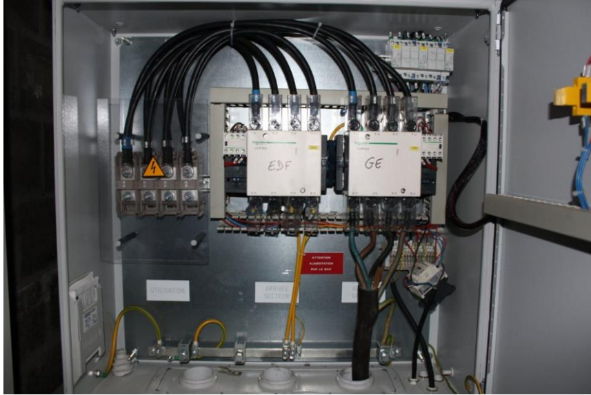
Inverseur triphasé automatique de secours N/S 80A,150A,250A et 400A.
