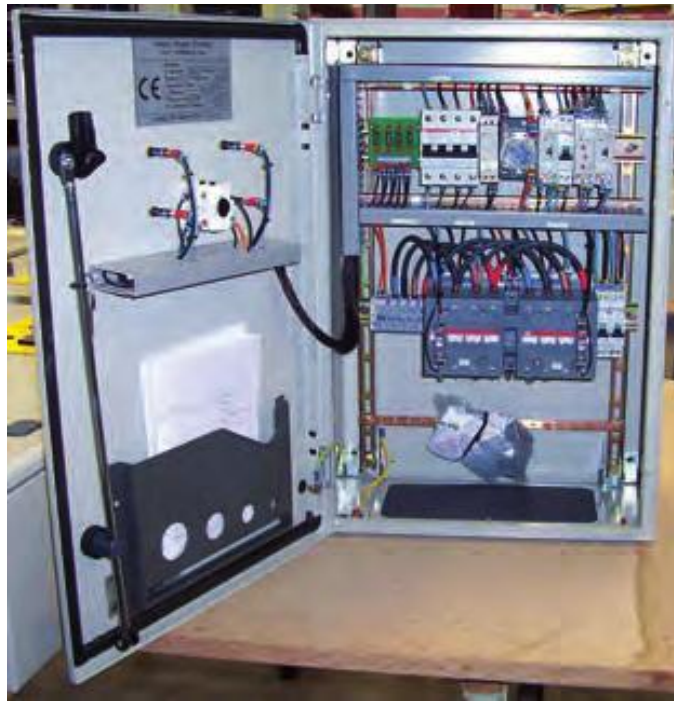
Inverseur triphasé automatique de secours N/S de 80A,150A,250A et 400A.
